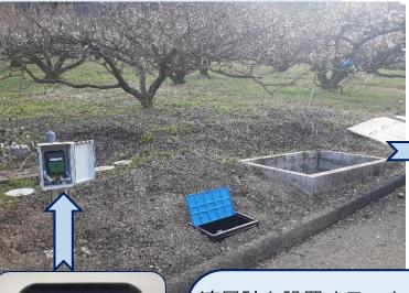
流量計を設置することで、 植栽へのかん水強度 (mm/h)/かん水量(m³)の管理や、漏水・かん水不具 合などのトラブルをいち 早く検知可能です。
